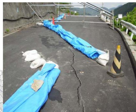
平成20年5月 9日 1. 滝ノ沢下流地区 管理用道路の亀裂・沈下
