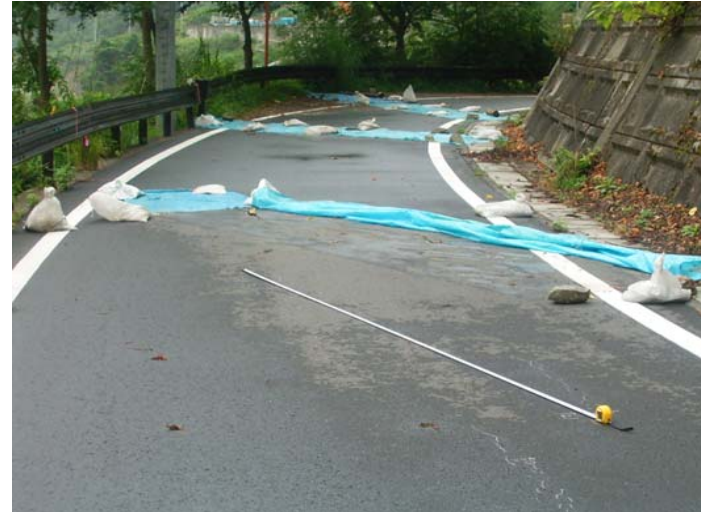
変状箇所近景
