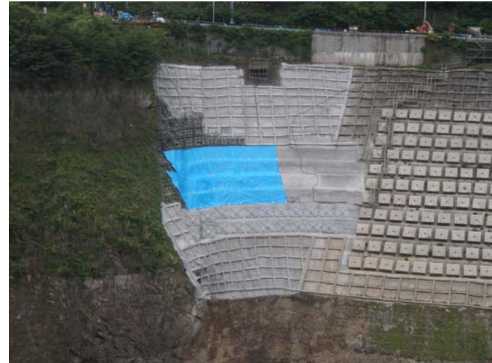
対策工実施中
