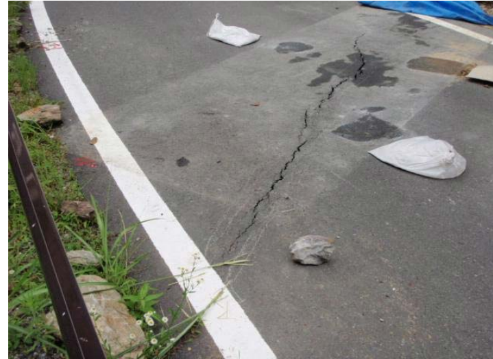
変状箇所近景
