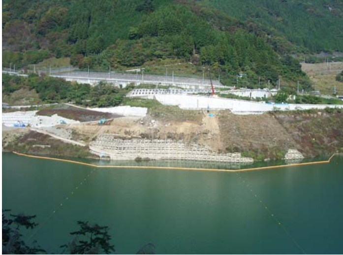
⑧ 滝ノ沢下流(L20下流)地区(対策済) 対策前
