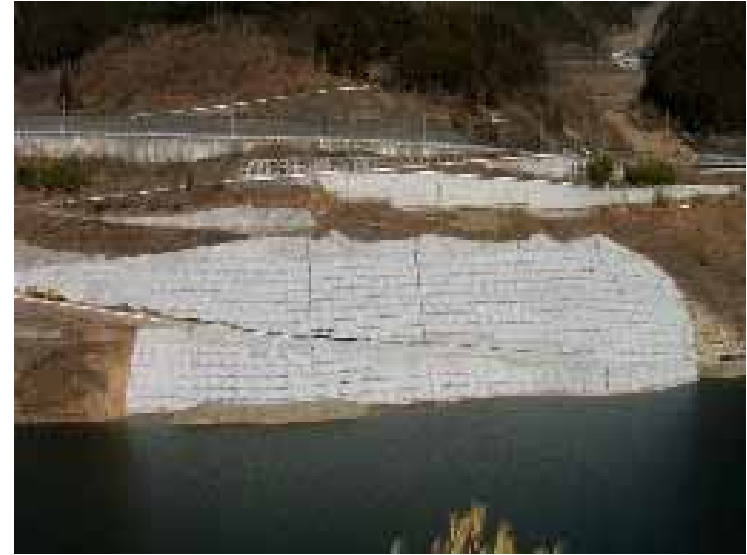
対策工事完了 H22.2
