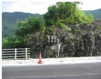
5. 埋設伸縮計設置状況
