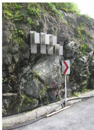
6. 埋設伸縮計設置状況
