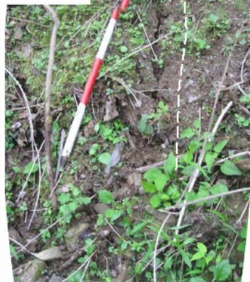
12. 側方部を示唆する亀裂。
