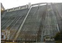
▲D 堤体下左岸側にある監査廊の入り口
