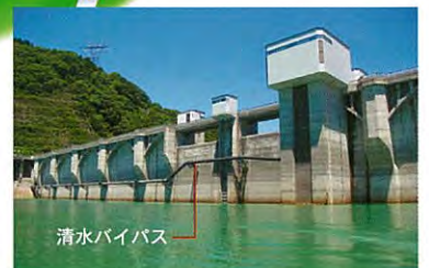
▲清水（せいすい）バイパス／洪水などでダムの水が濁っても、貯水池上流のきれいな水を下流へ流せるよう、貯水池沿いに整備された約6.0kmのバイパス水路。
