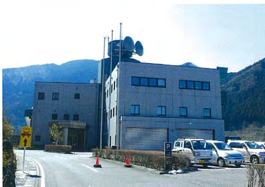
【荒川ダム総合管理所(浦山ダム)】
