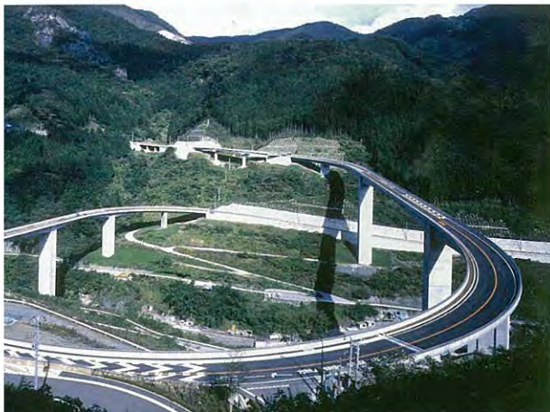
にかかる美しいループ状の「大滝大橋」と「甘六木大橋」
