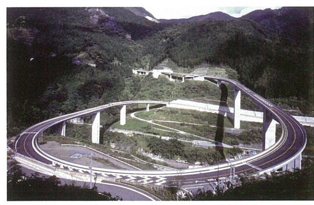
ダム直下流のループ橋
