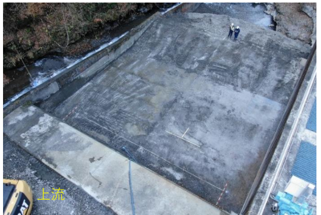
取水堰堆砂除去後
