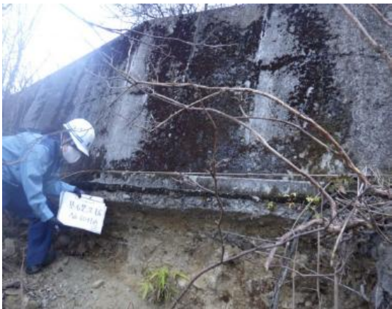
コンクリート基礎洗掘 (No.60付近)
