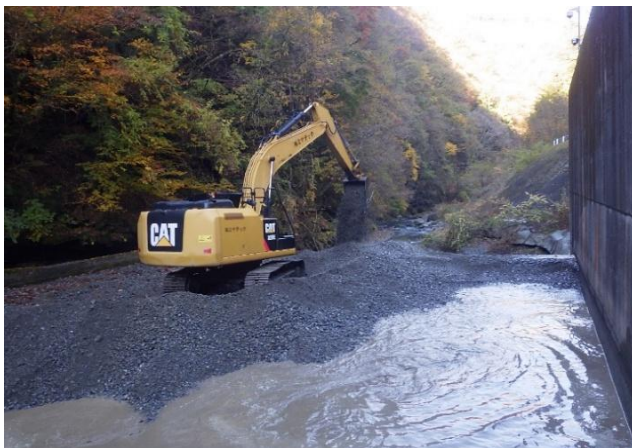
取水堰堆砂除去状況
