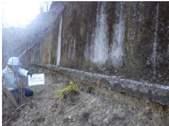
コンクリート基礎洗掘 (No.62付近)
