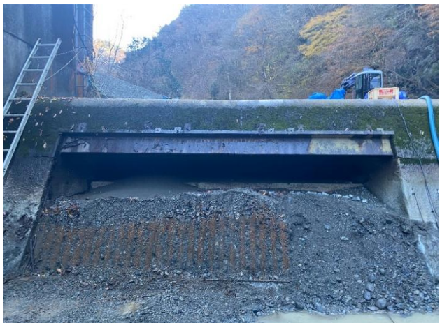
取水堰スクリーン内堆砂状況
