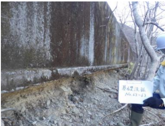
コンクリート基礎洗掘 (No.63付近)
