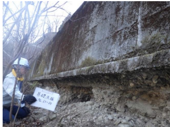
コンクリート基礎洗掘 (No.64付近)
