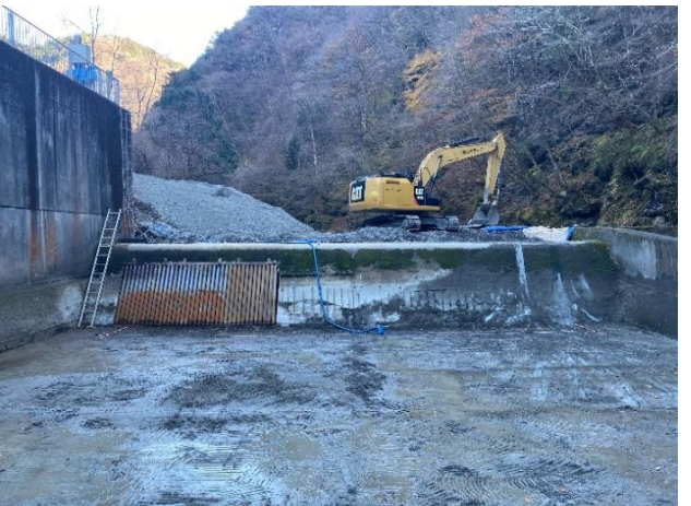
取水堰堆砂除去後
