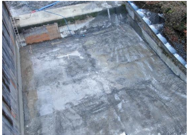
取水堰堆砂除去後
