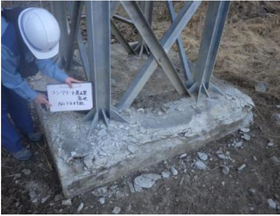
コンクリート基礎劣化状況 (No.58付近)
