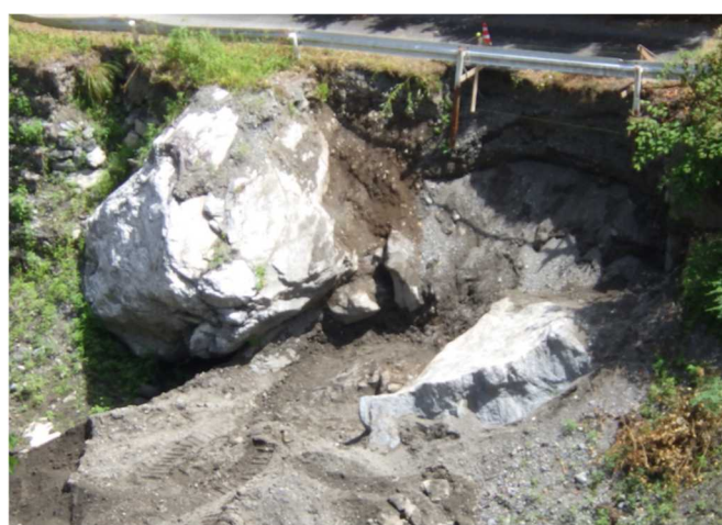
大型土のう設置前の基礎地盤状況
