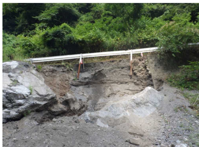
大型土のう設置前の基礎地盤状況
