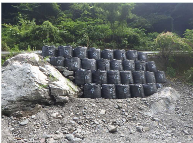
大型土のう設置状況（現況）
