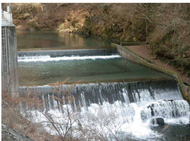
出水時に取水堰からの越流状況
