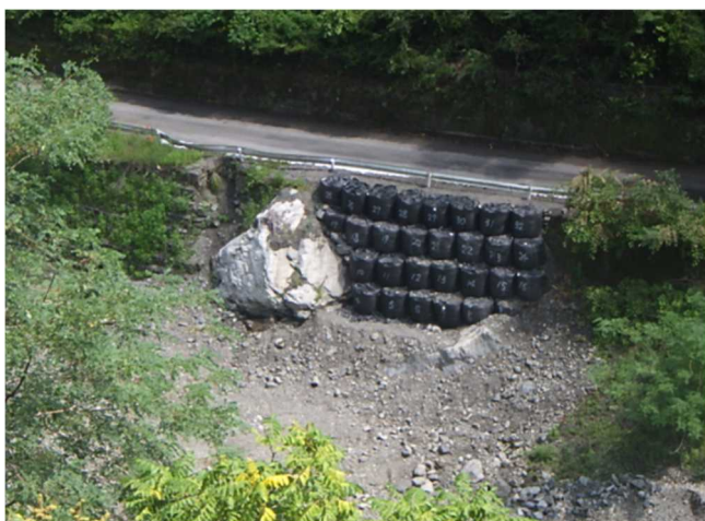
大型土のう設置状況（現況）
