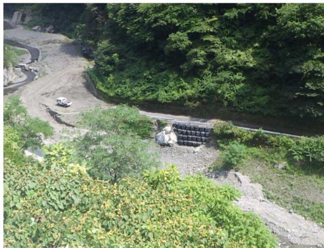
大型土のう施工後
