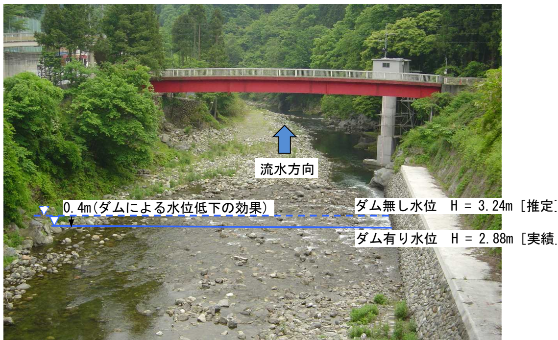
中津川大平橋
