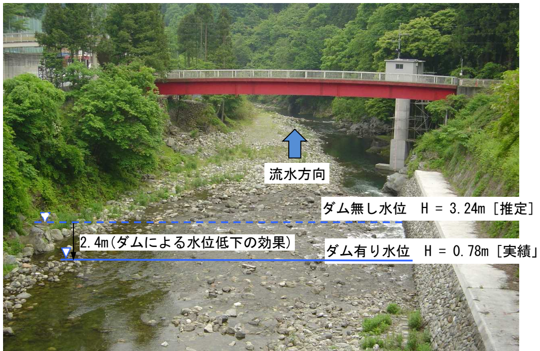
中津川大平橋
