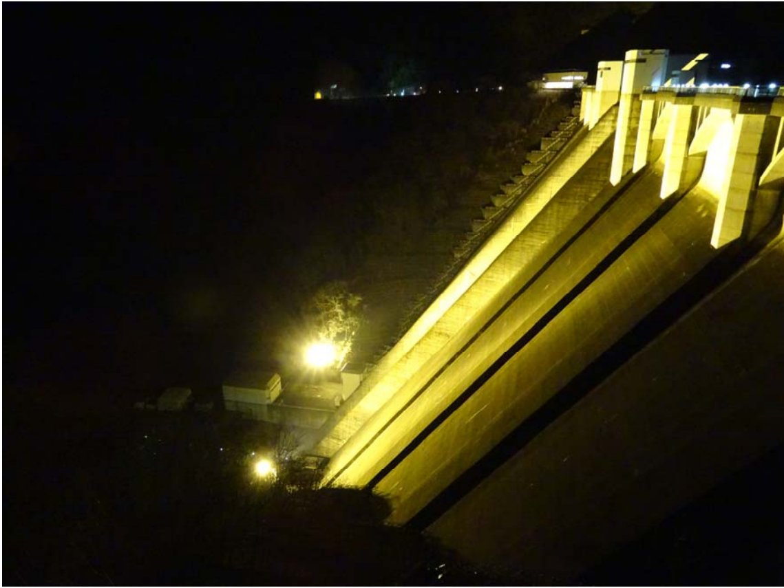
(写真1 : 浦山ダム左岸より)
