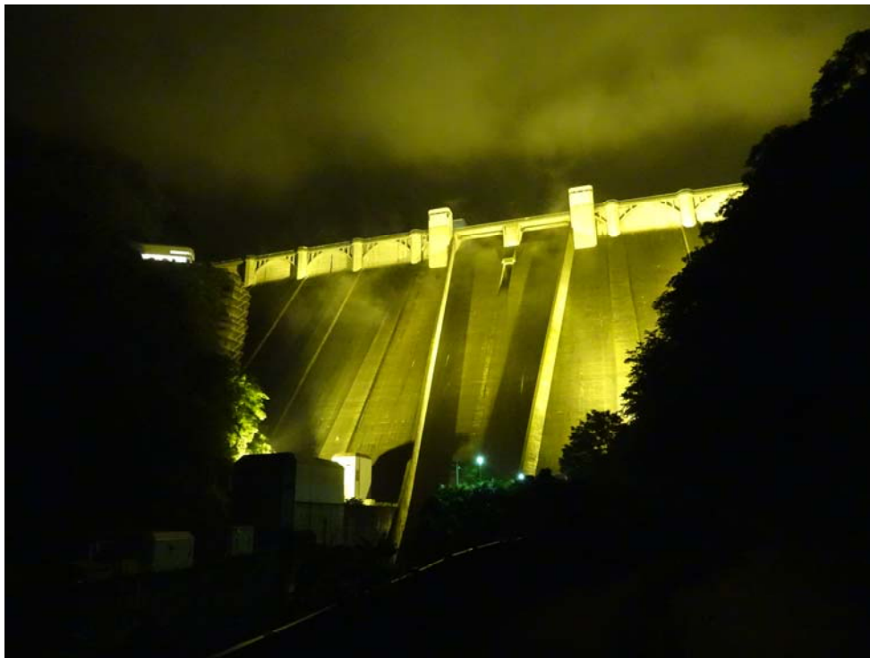
浦山ダム下流から
