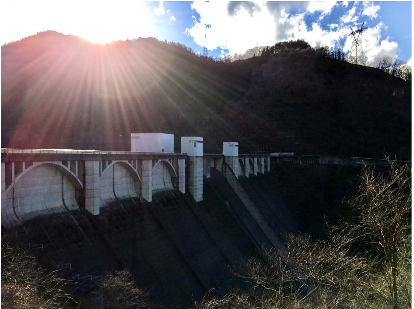
暮れなずむ堤体(浦山ダム)
