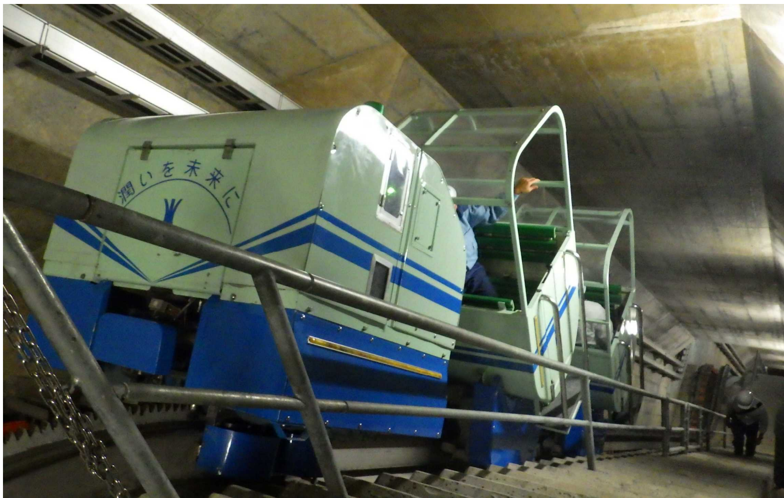
モノレールによる堤体内の点検（浦山ダム）
