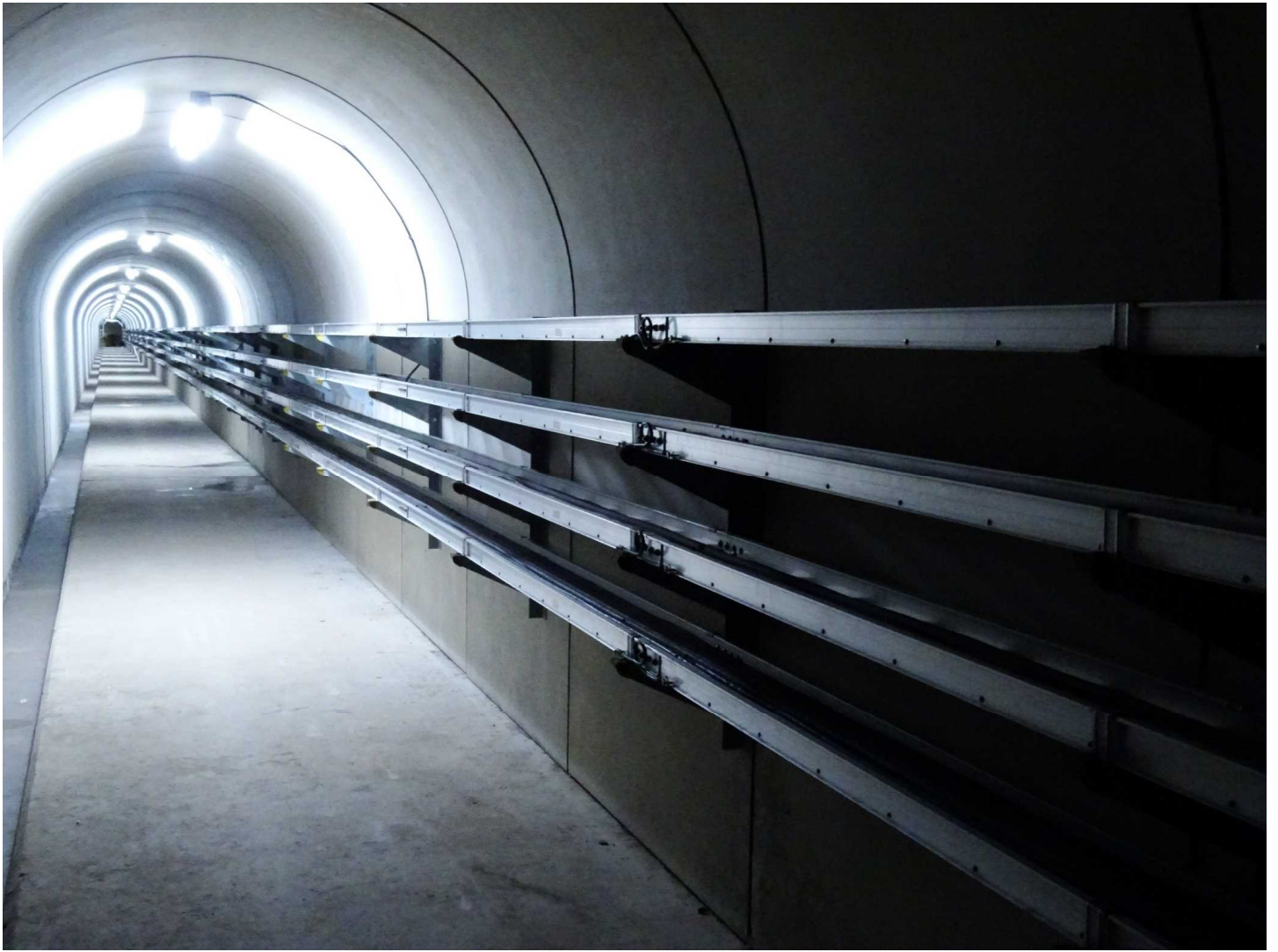
監査廊（滝沢ダム）
