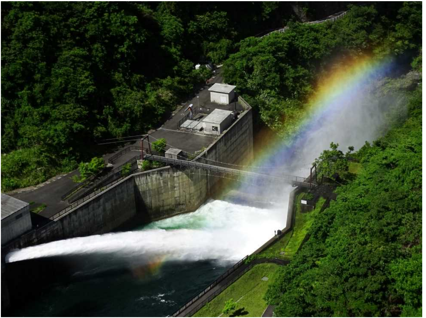
主管放流設備からの放流（滝沢ダム）
