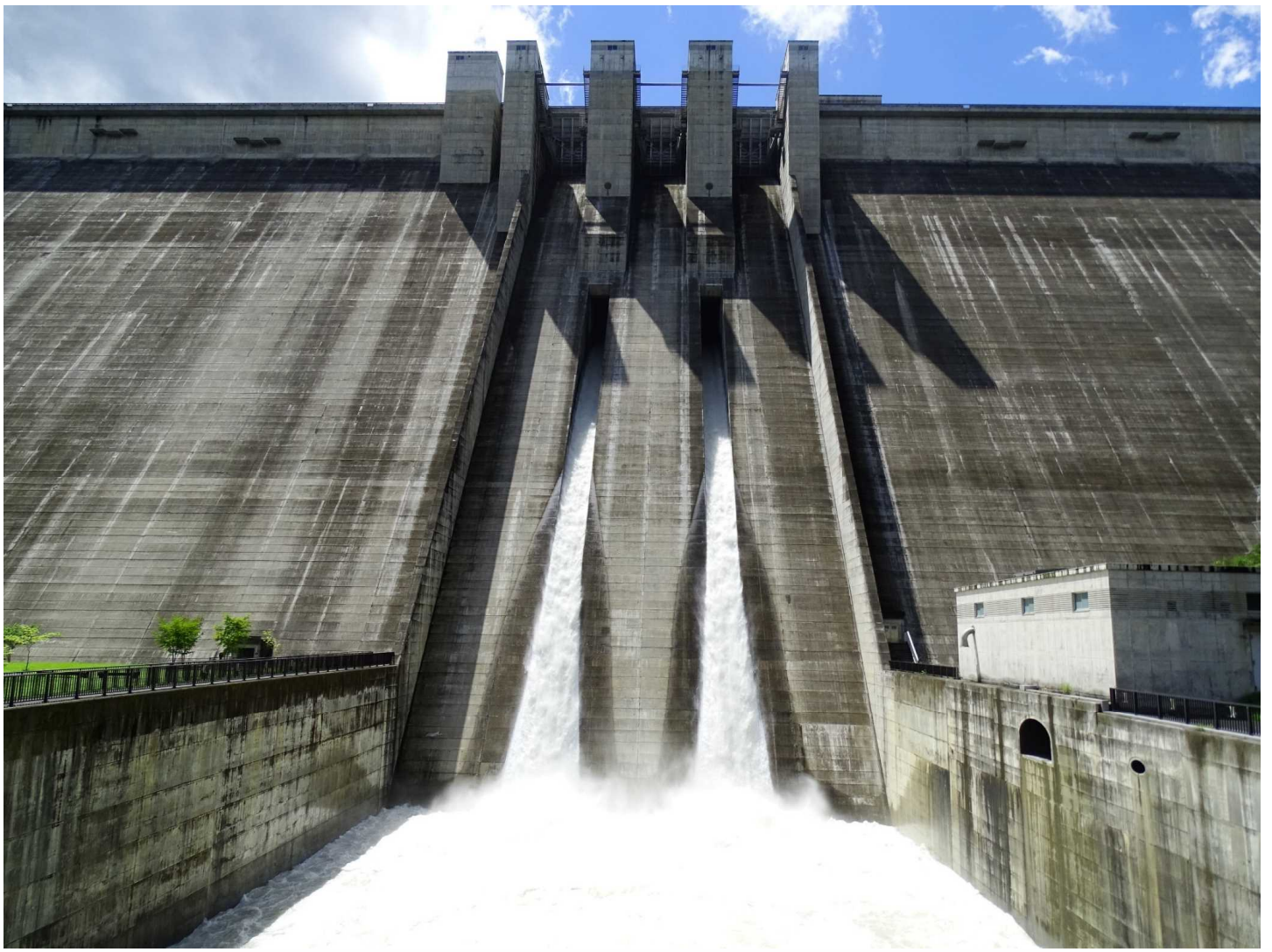
ゲート放流（滝沢ダム）
