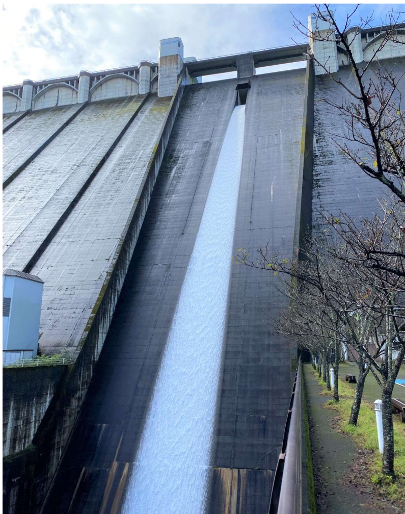
常用洪水吐からの自然越流（浦山ダム）
