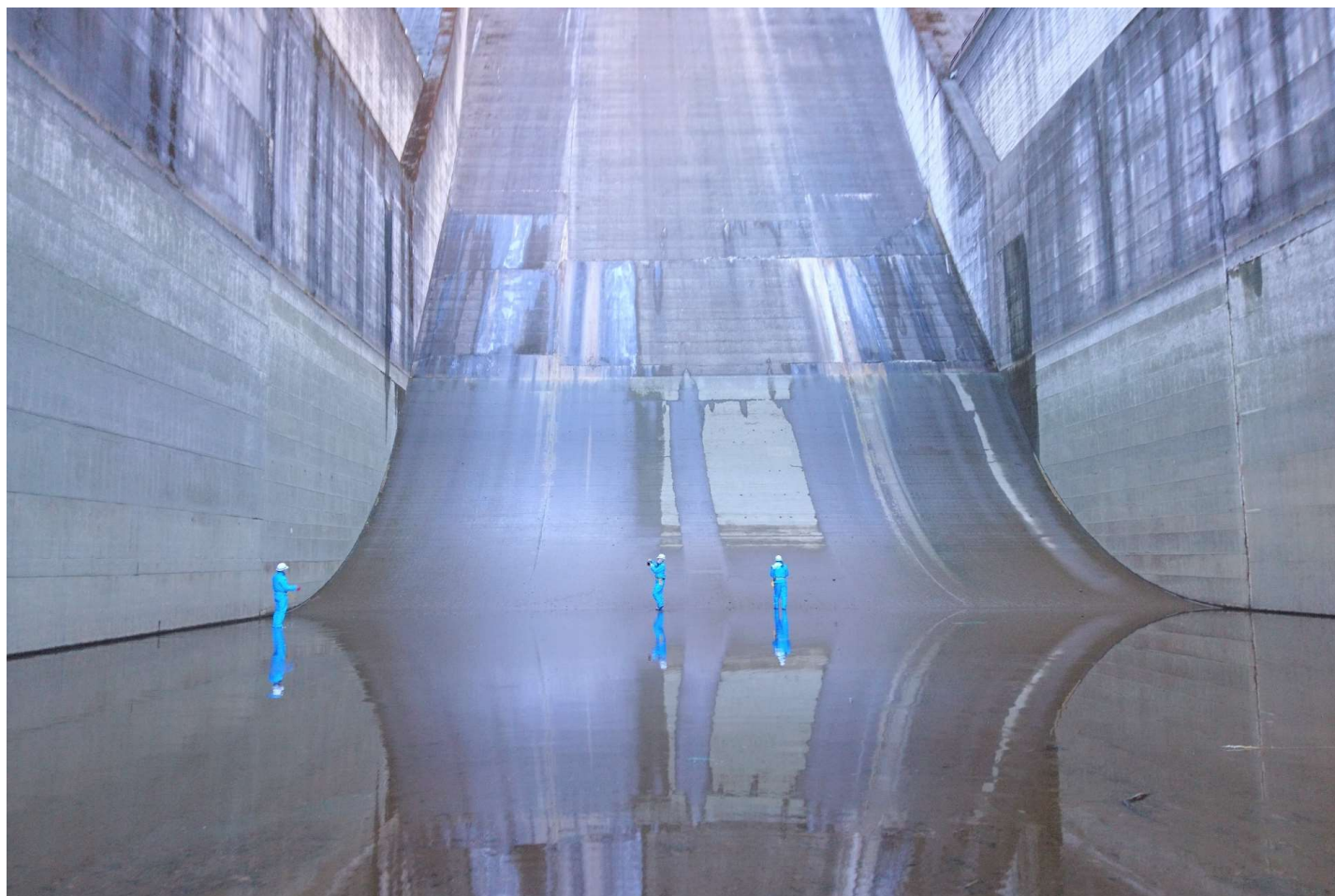
減勢池点検（浦山ダム）
