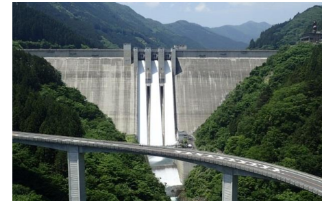
滝沢ダム(水資源機構)
