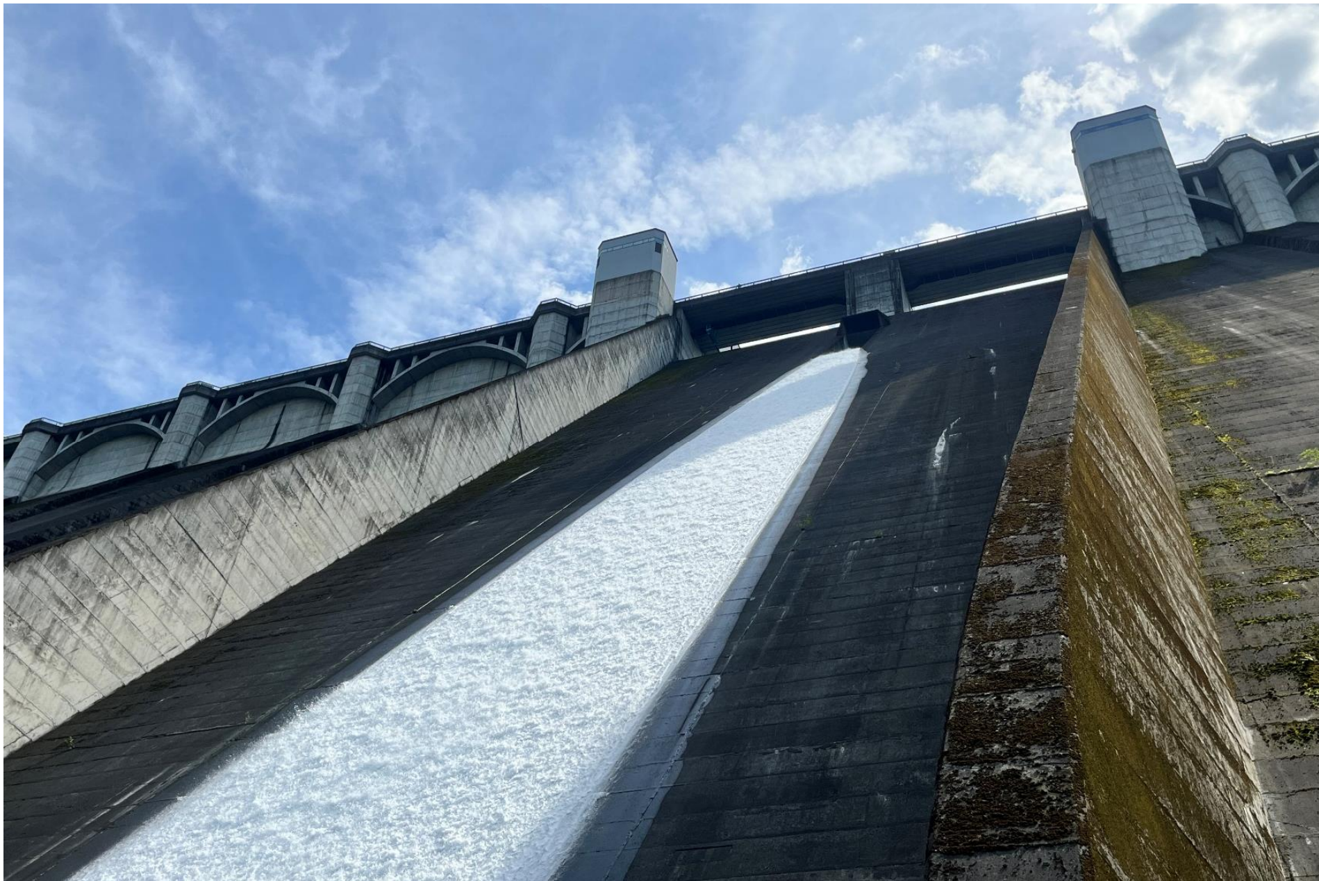
常用洪水吐からの放流（浦山ダム）
