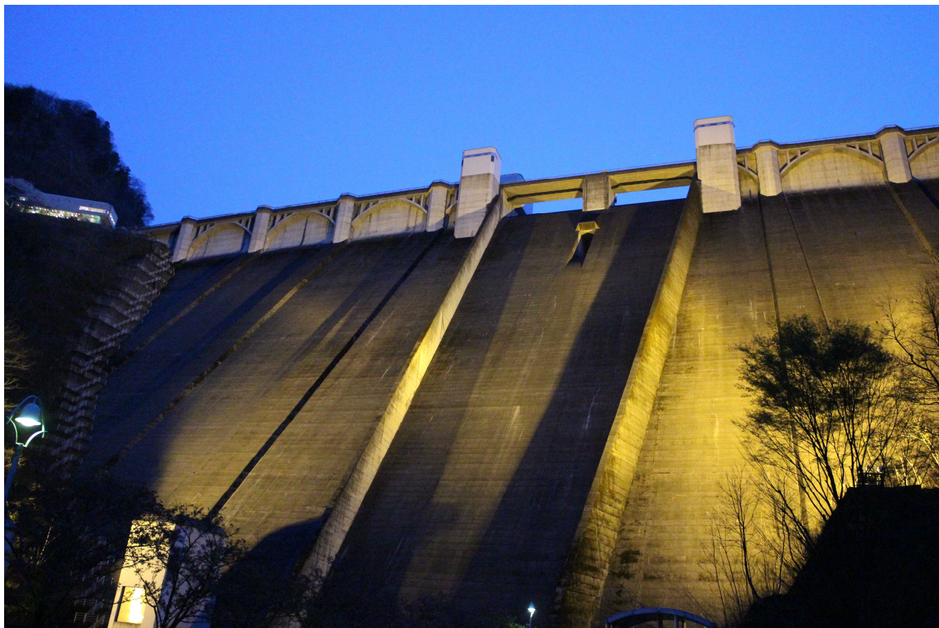
ライトアップ（浦山ダム）
