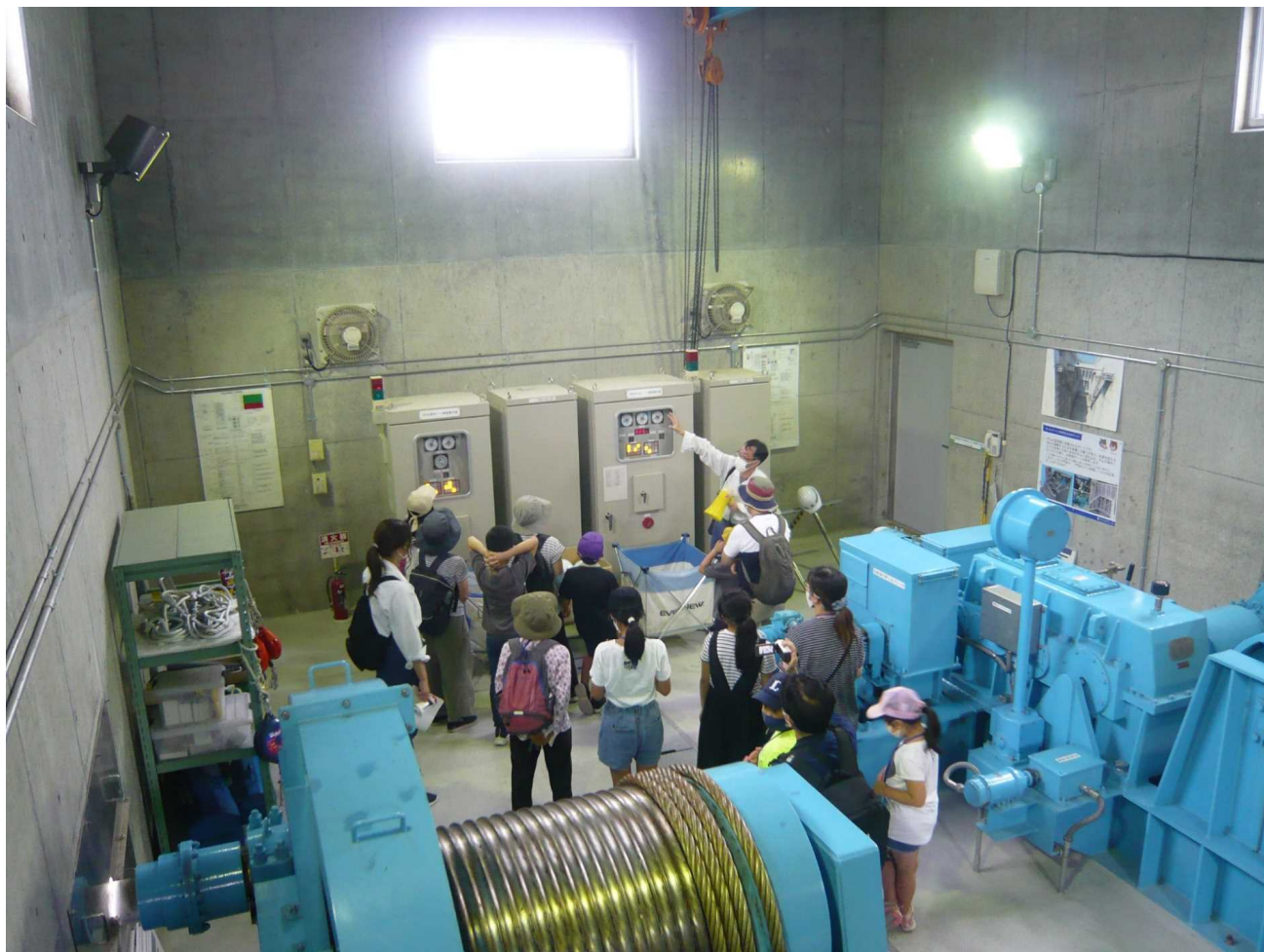
秩父4ダム探検隊が往く！（滝沢ダム：ゲート操作室）
