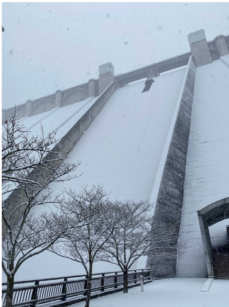
雪景色（浦山ダム）
