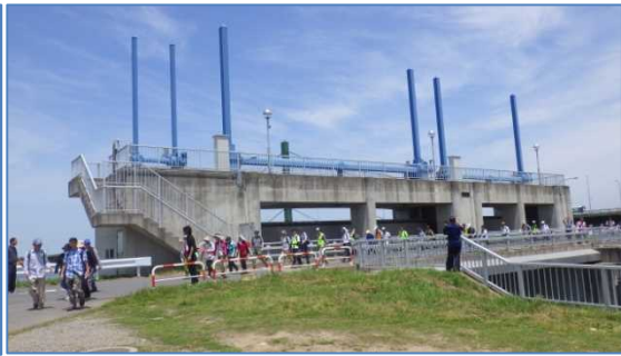
利根川両総水門（共用）
