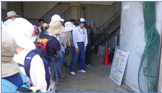
第一揚水機場（共用：都市用水ポンプ場）
