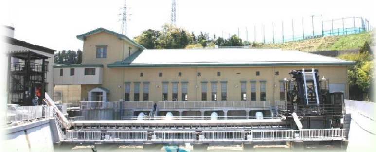
【両総用水第一揚水機場】
