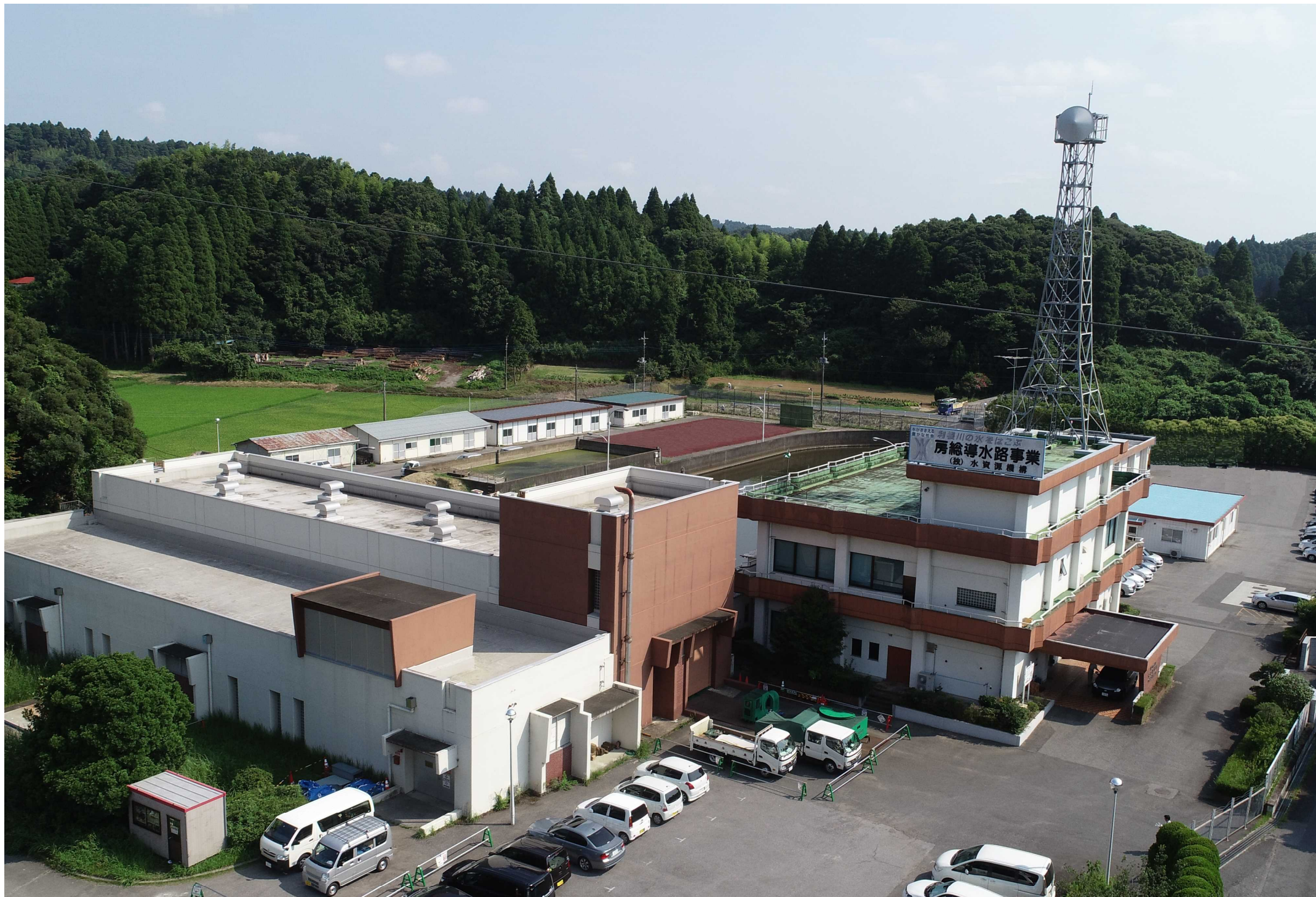
【房総導水路事業所(大網揚水機場)】
