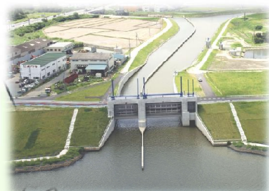
【利根川両総水門】
