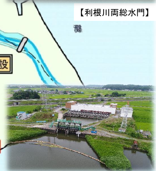
【緑に映える横芝揚水機場】
