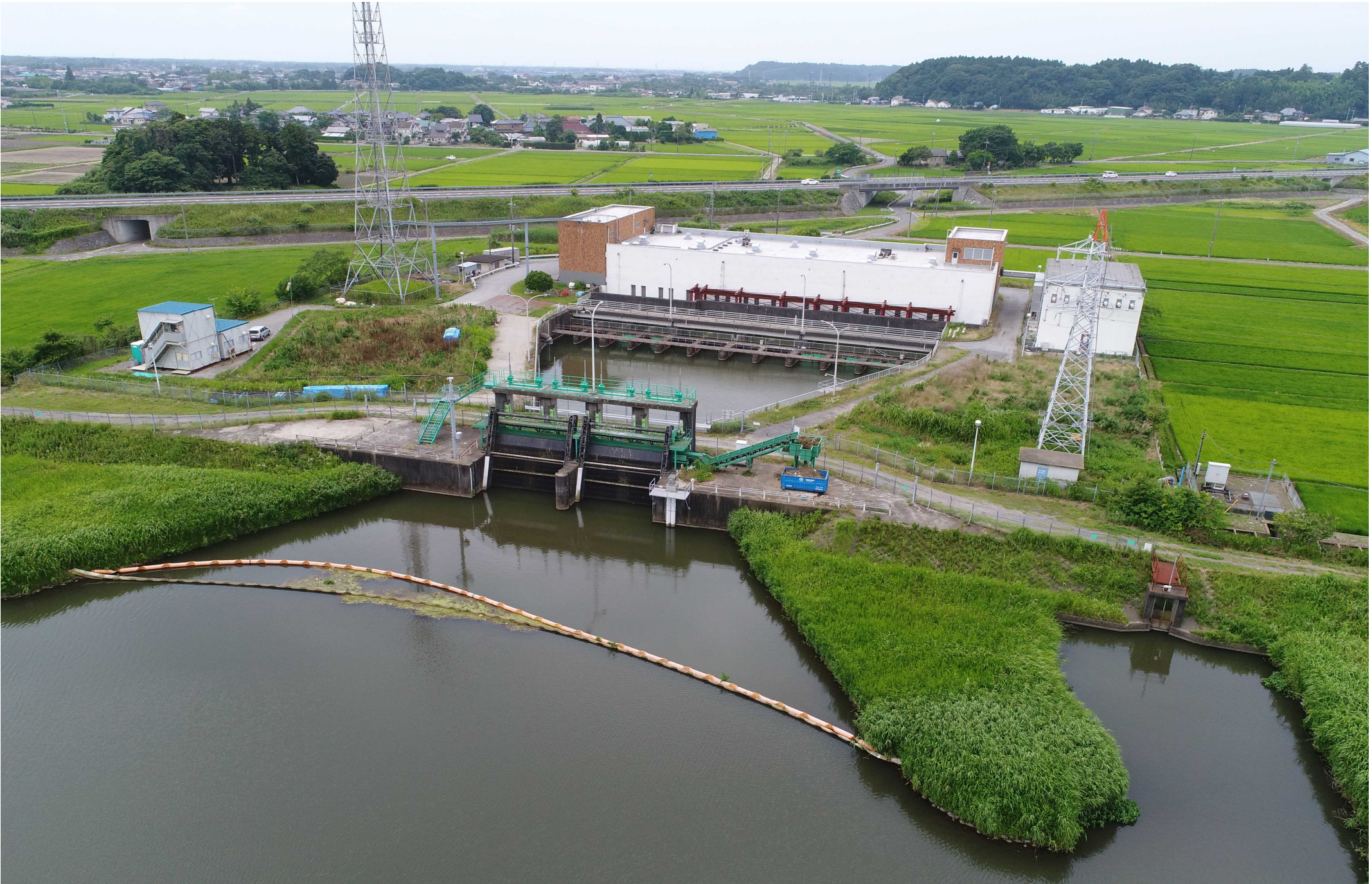
【緑に映える横芝揚水機場】
