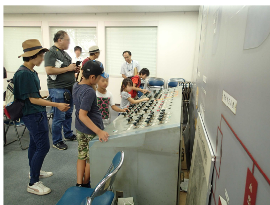
緊急改築前の旧ポンプ操作設備に触れて
