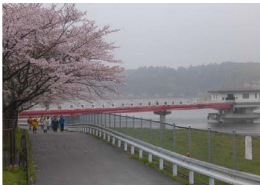
長柄ダム湖畔の桜と取水塔
