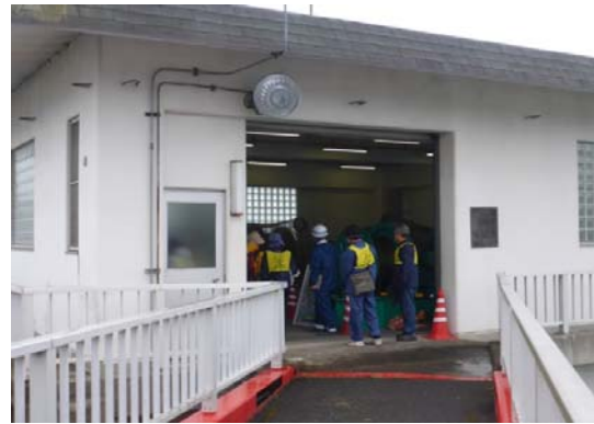
取水塔の開放
