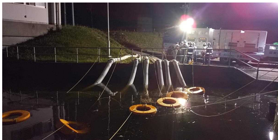
宗吾北機場へのポンプ6台設置状況
