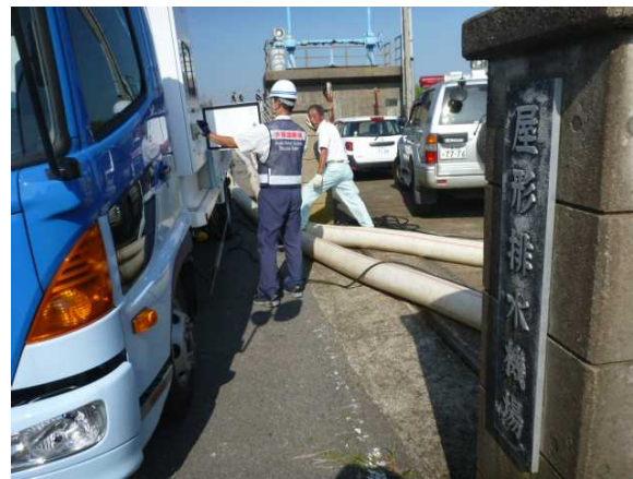
排水ポンプ車設置状況（屋形排水機場）
