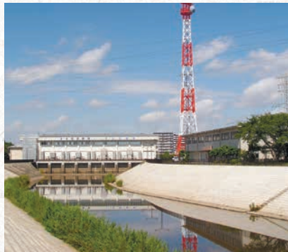
大和田排水機場
