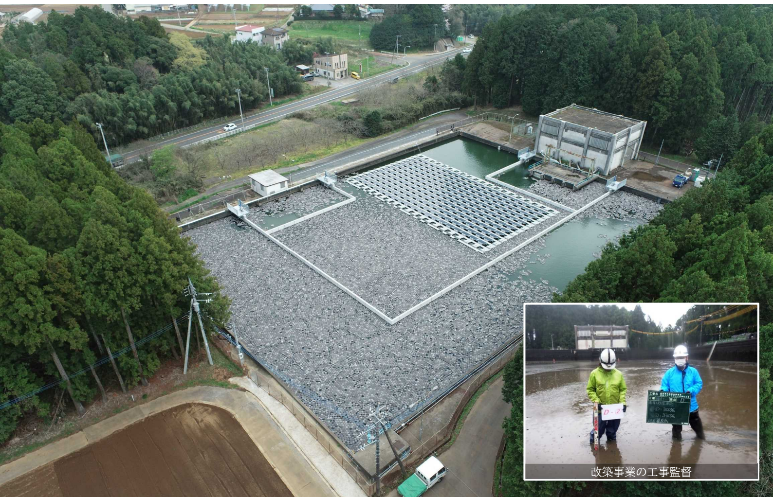
改築後の高田ファームpond【成田用水】
