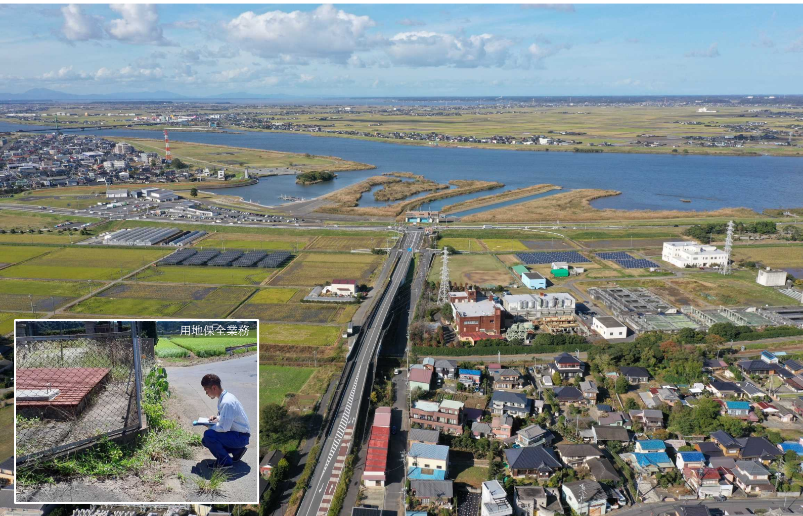
北総東部用水取水工（写真中央）と利根川・霞ヶ浦【北総東部用水】
