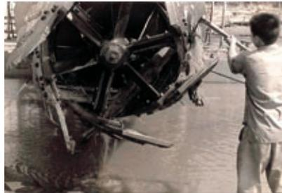
花見川開削時(昭和28年)、カッターに引っかかった古杭を取り除くところ。工事中には、江戸時代のものと思われる数千本の杭が見つかった。“詰めグイ”と呼ばれる護岸づくりの工法で、当時の工事の苦勞が偲ばれる。
