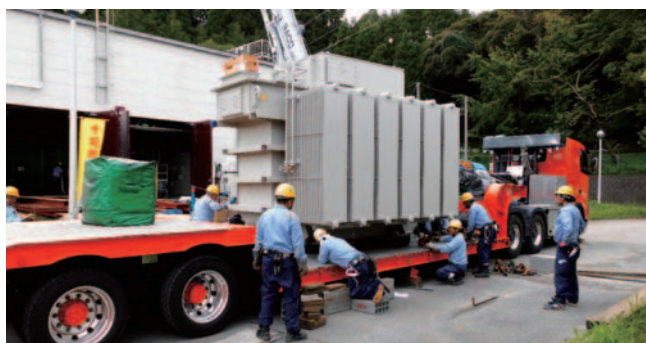
大網揚水機場特高変圧器搬入状況
