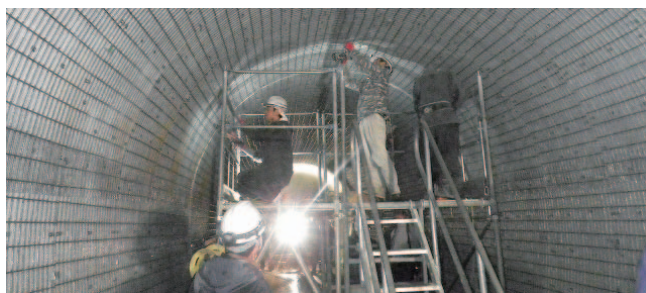
21-3 号トンネル耐震補強
