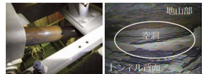
特別高圧受変電設備の機器破損
