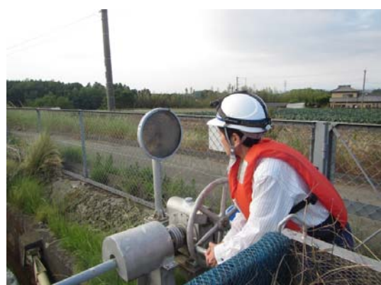
増やした水が上流から流れ着いたかを各地点の水路の壁につけられた目盛りを見て確認しながら、チェックゲートを操作します。
