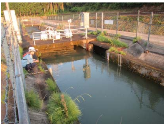
増やした水が上流から流れ着いたかを各地点の水路の壁につけられた目盛りを見て確認しながら、チェックゲートを操作します。
