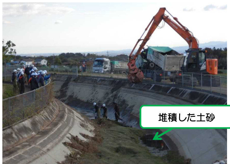
重機による土砂撤去の状況です
