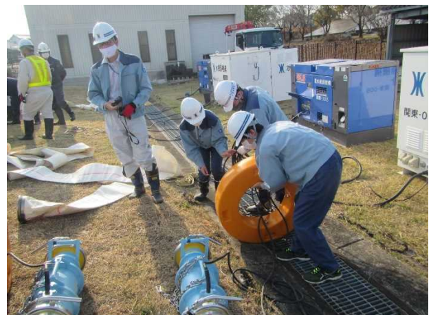
ポンプ設備の設営
