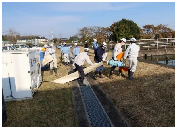
ポンプの運搬（重い！）
