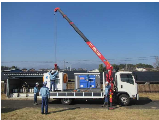
クレーン操作による積み込み
