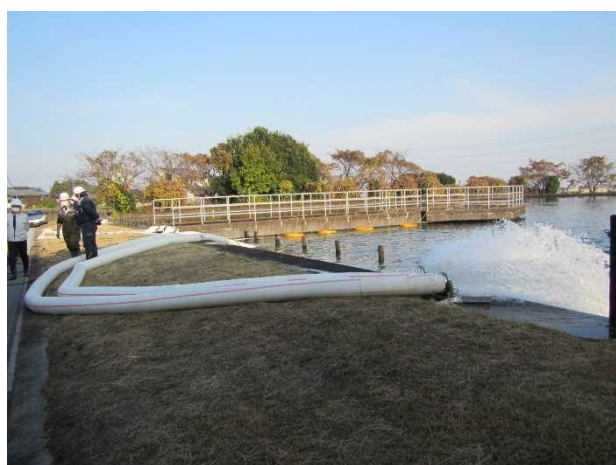
ポンプ運転による排水
