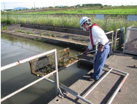
水路の除塵作業
