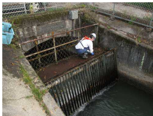
トンネル入り口の除塵作業
