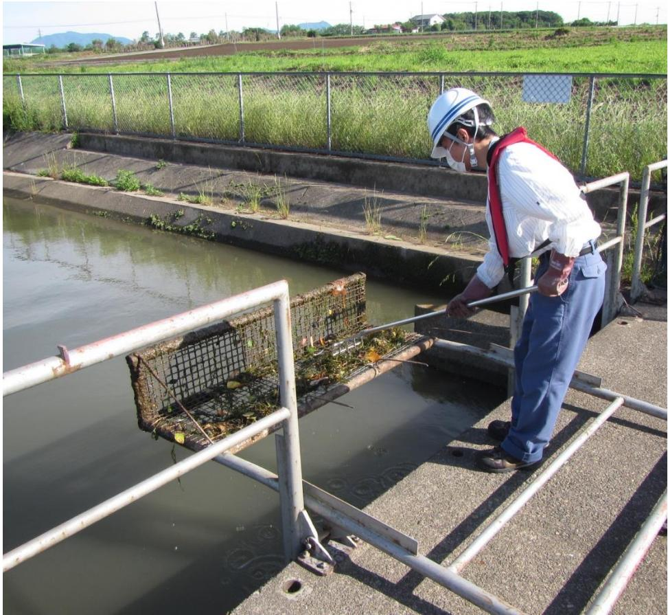
安定通水のためのゲート操作、除塵作業
