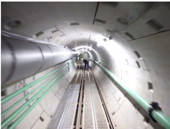
トンネル内部を歩きました
