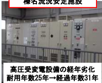
榛名流況安定施設
