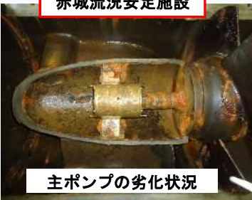
赤城流況安定施設
