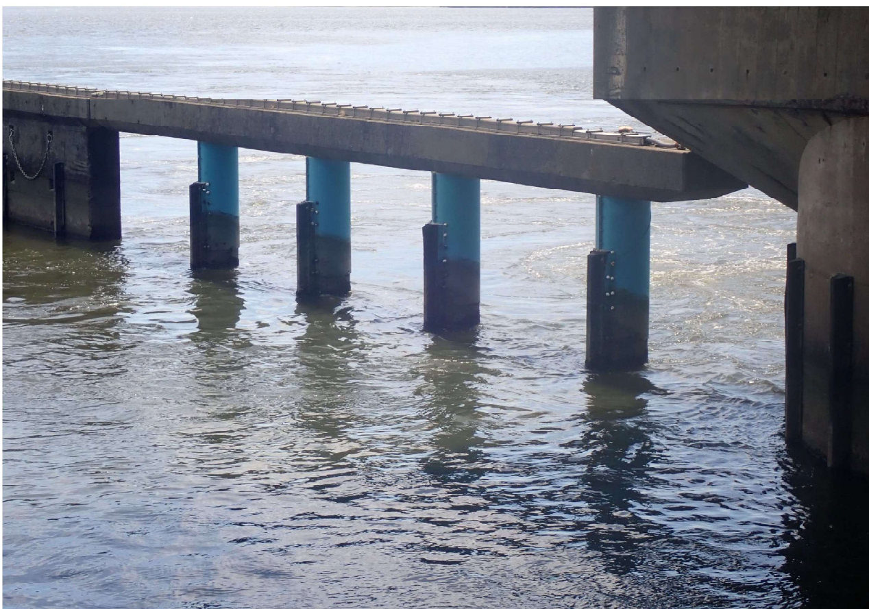
利根川河口堰下流導流堤 外観写真
