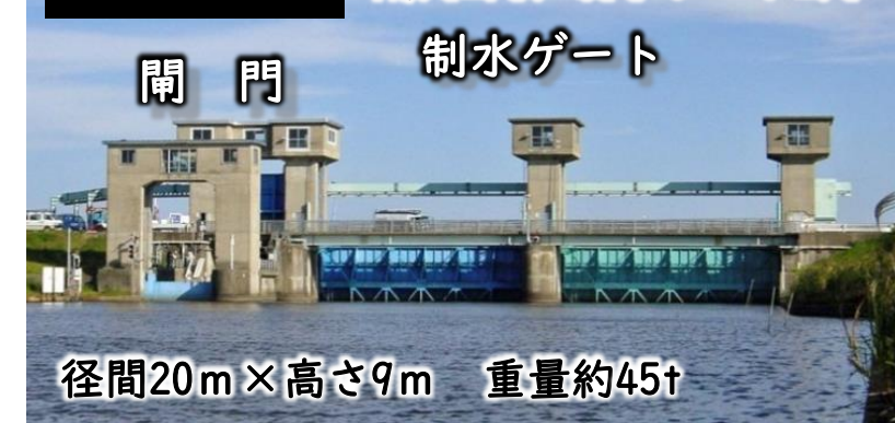
黒部川水門 閘門2門、制水ゲート2門
