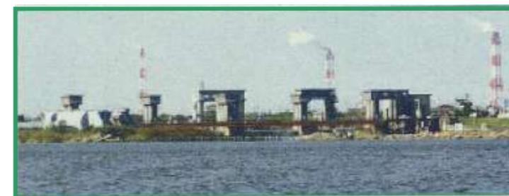
④常陸川閘門
