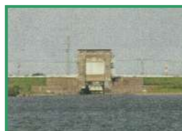
⑥小見川閘門
