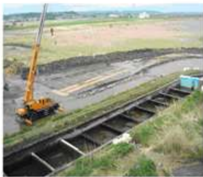
右岸魚道改築工事
