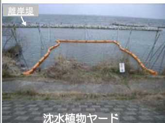
沈水植物ヤード
