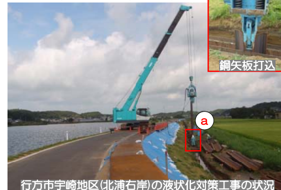
行方市宇崎地区(北浦右岸)の液状化対策工事の状況
