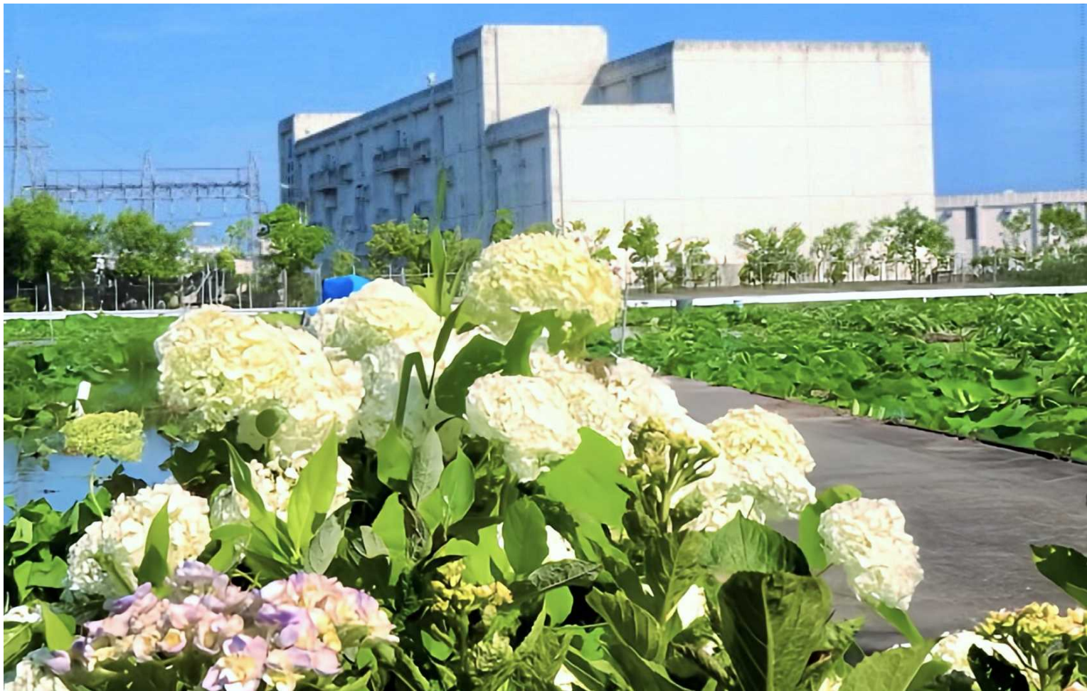
【霞ヶ浦揚水機場（霞ヶ浦用水）】
