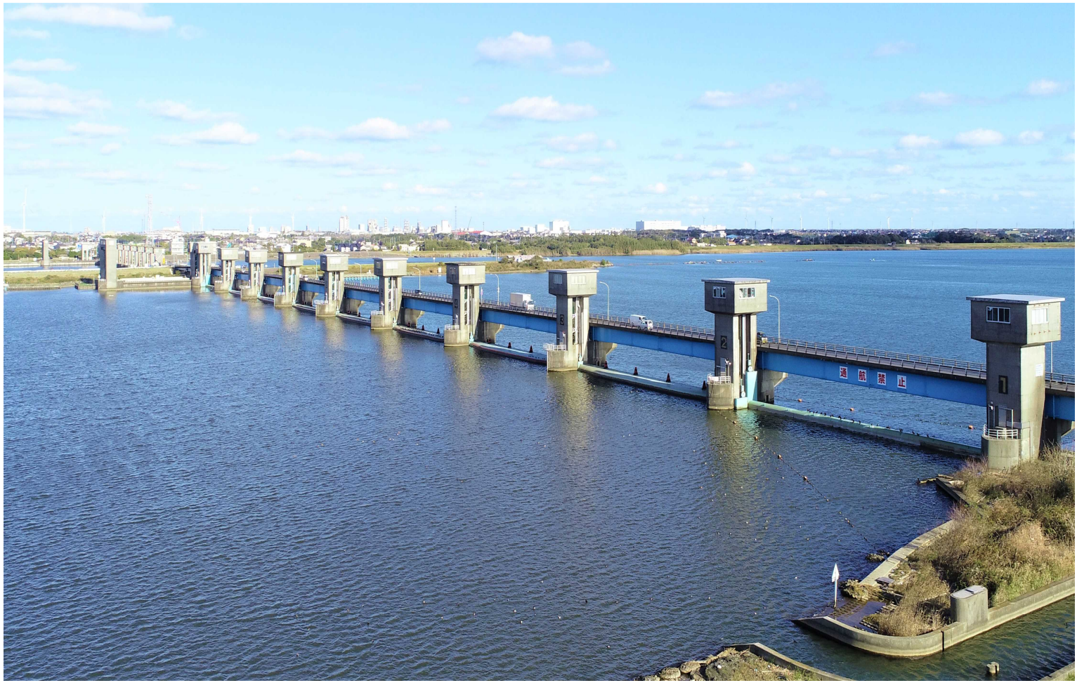
【利根川河口堰】
