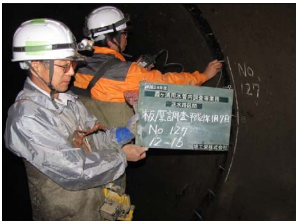
板厚調査（平成28年度実施状況）
