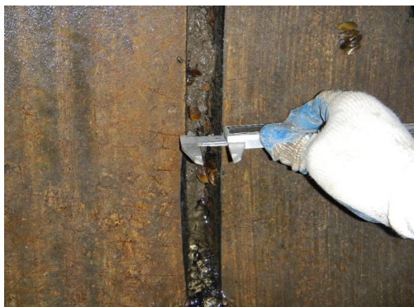
継ぎ目間隔調査（平成28年度実施状況）
