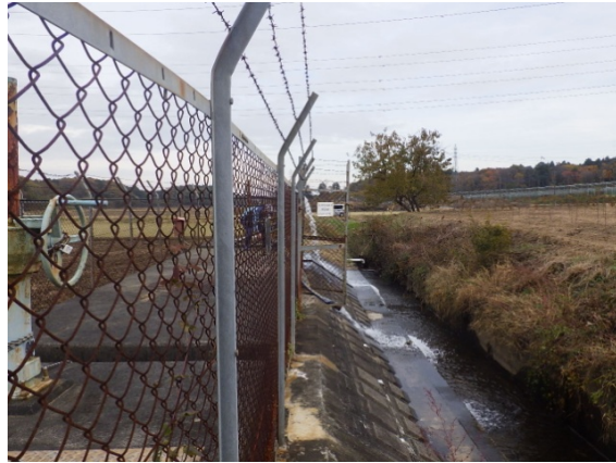
排水ポンプによる排水中
