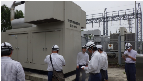
予備発電機起動操作訓練
