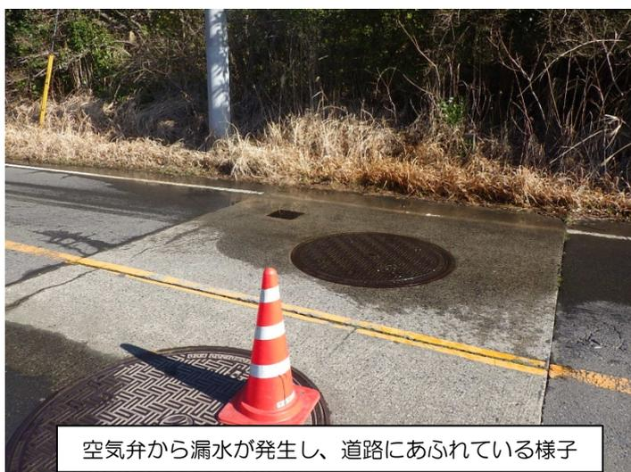
空気弁から漏水が発生し、道路にあふれている様子
