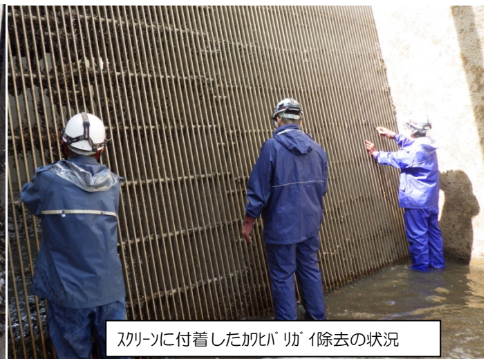
コンクリート壁に付着したカワヒバリガイ除去の様子
