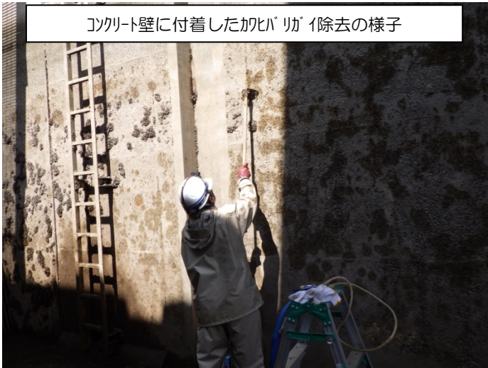
コンクリート壁に付着したカワヒバリガイ除去の様子
