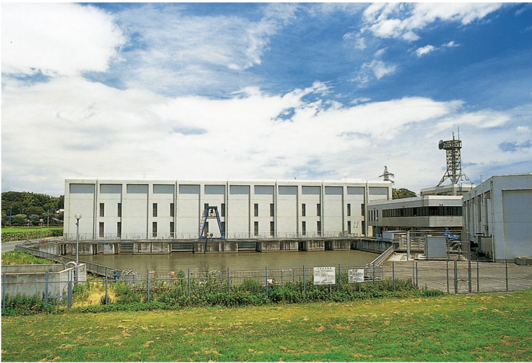
▲霞ヶ浦揚水機場
