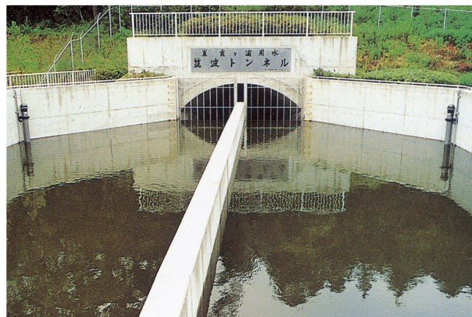
▲筑波トンネル入口
