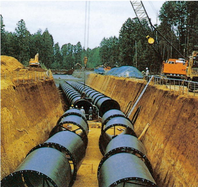
▲建設中のパイプライン
