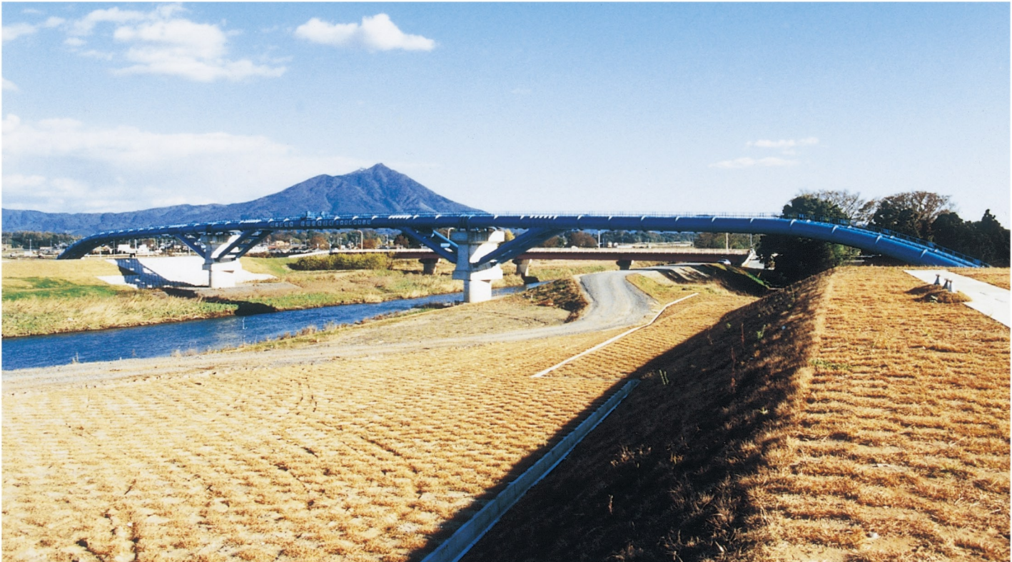
▲小貝川水管橋
