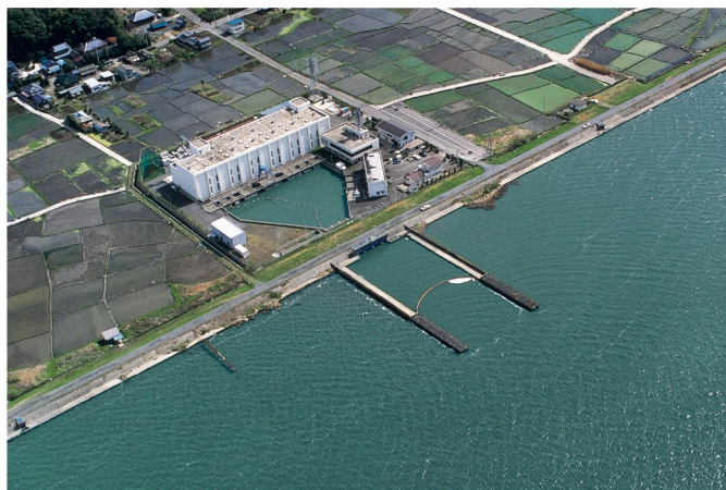
▲霞ヶ浦揚水機場
