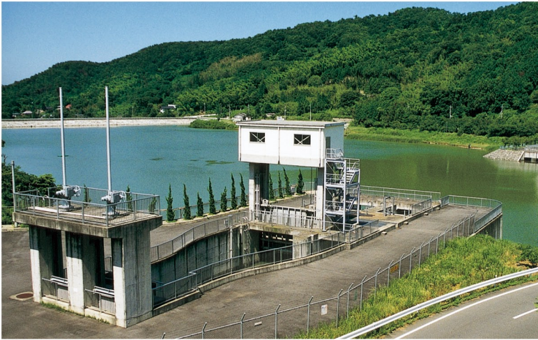
▲南椎尾調整池取水工
