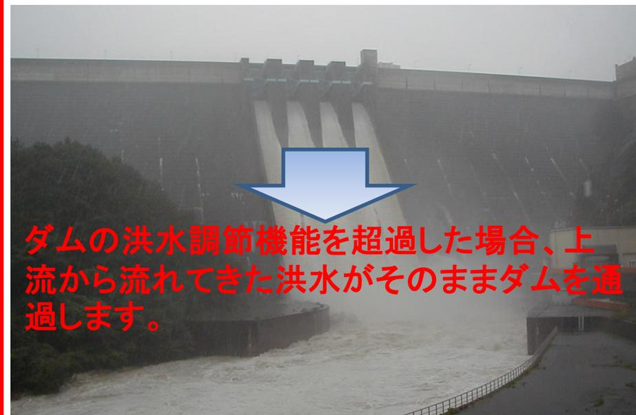
ダムの洪水調節機能を超過した場合、上流から流れてきた洪水がそのままダムを通過します。
