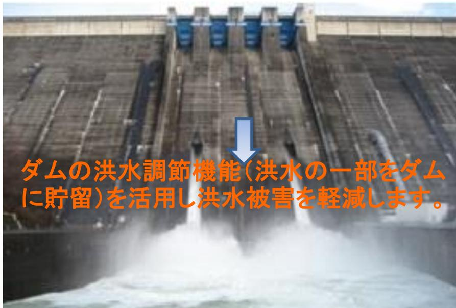
ダムの洪水調節機能(洪水の一部をダムに貯留)を活用し洪水被害を軽減します。
