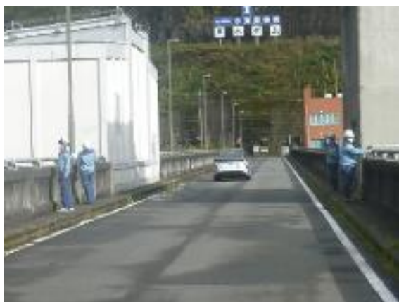
ダム天端の欄干の点検
