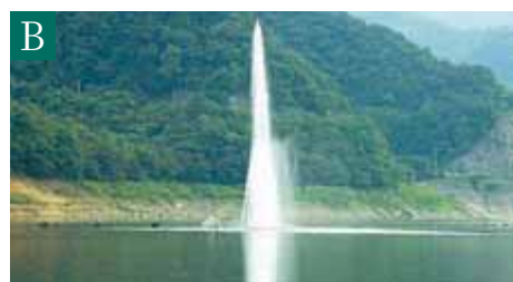
■噴水合体型散気管式循環装置 噴水は、ポンプの力でプランクトンを減らします。
