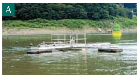
■散気管式循環装置 草木湖に4基配置しています。
