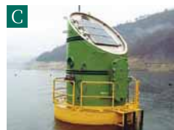
■水質自動監視装置（たけのこ） 水温、pH、濁度、溶存酸素電気伝導度クロロフィルaを毎正時計測しています。
